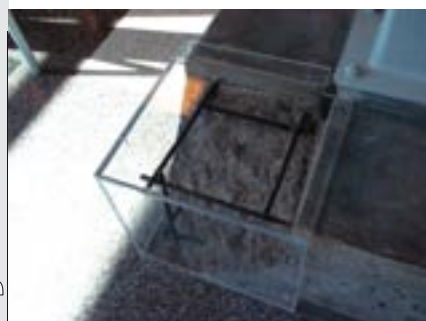
Zgrada Građevinskog fakulteta na Utah State University, USA; detalji konstrukcije tretirani kao eksponat građevinske tehnologije
